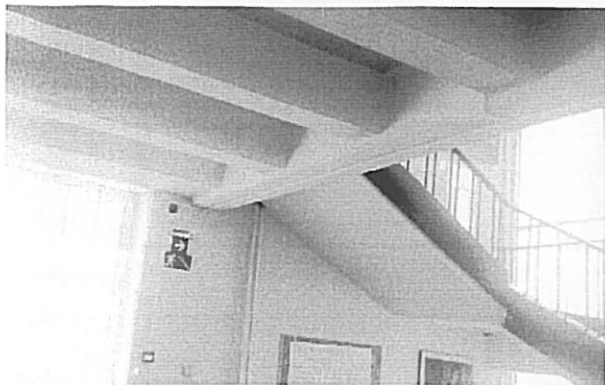
Снимка: Стоманобетонни плочи, греди и колони, изграждащи носещата конструкция на корпус Б.
