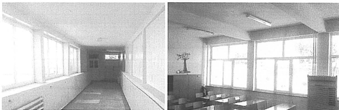
Снимка: Стоманобетонни плочи и греди, изграждащи носещата конструкция на корпус А.
